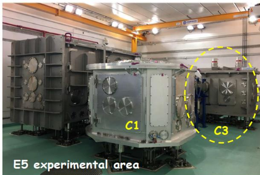
Sala experimentală E5 este dedicată experimentelor cu pulsuri laser de 1 PW.
