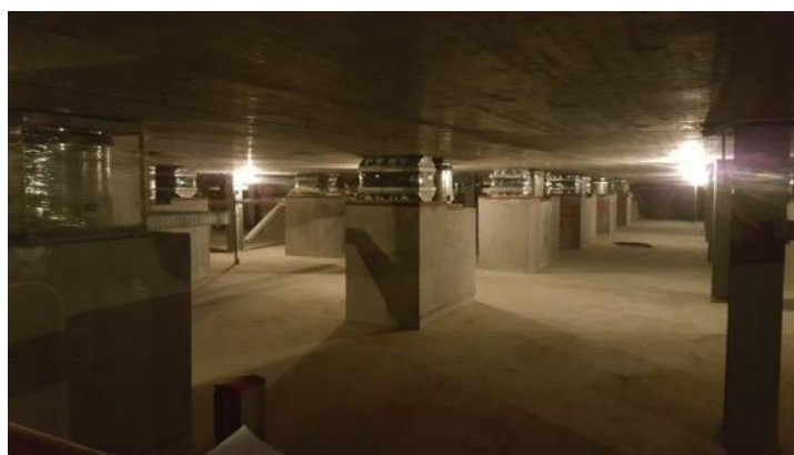
Imagine de la subsolul clădirii speciale ELI-NP arătând stâlpii de susținere cu arcuri și amortizare a platformei antivibrație.
